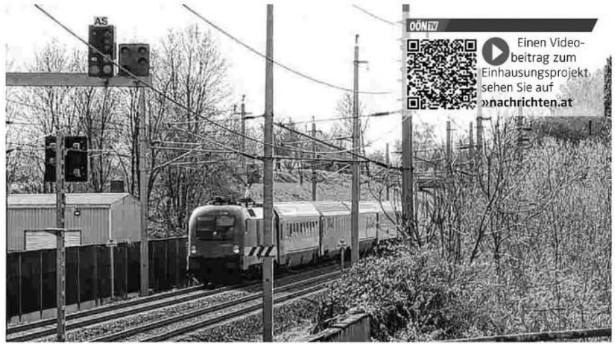
Auf maximal 360 Meter Länge wird die Westbahnstrecke im Zuge des vierspurigen Ausbaus eingehaust.
