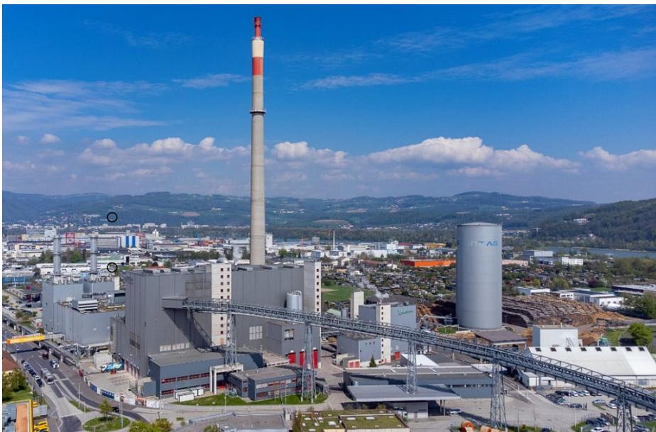
Bildtext: Der Kraftwerkspark Linz-Mitte beinhaltet ein Fernheizkraftwerk, ein Biomasse-Heizkraftwerk, ein Reststoff-Heizkraftwerk und einen Fernwärmespeicher.
