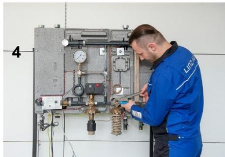
Abb. 4, 5: Installation von Übergabestationen mit digitalem Wärmemengenzähler.
