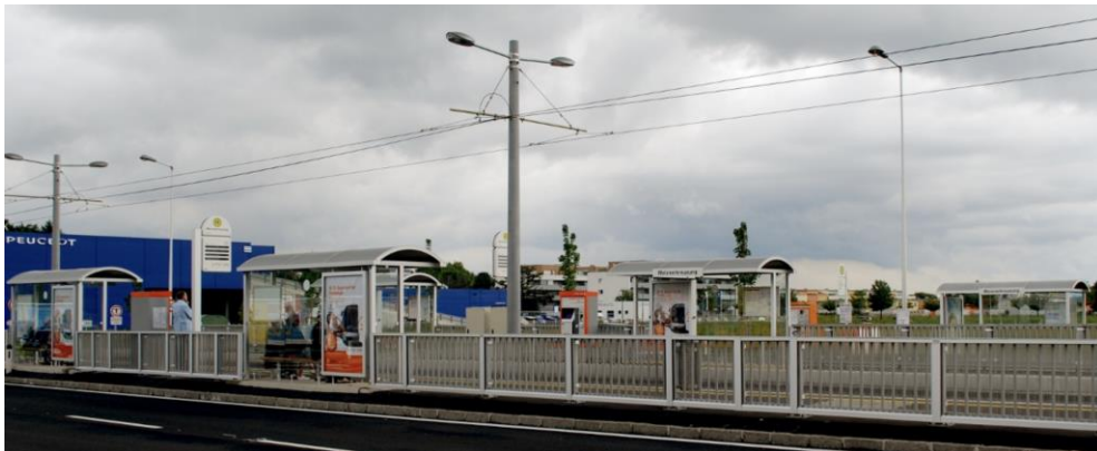
Abbildung 4.16: hochfrequentierte S-Bahn Haltestelle Meixnerkreuzung in hochversiegeltem Umfeld
