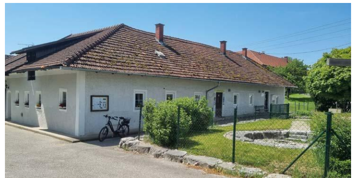
Das Dach des traditionsreichen Ruflinger Dorfstadels braucht dringend Erneuerung.
