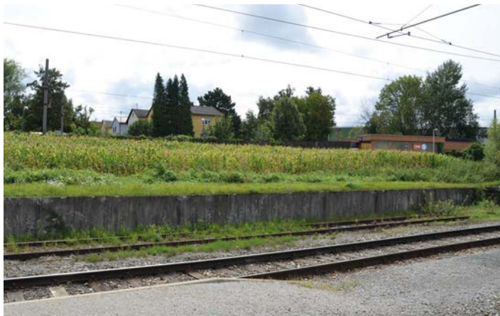
Der Blick von den LIL0 Gleisen Richtung Bahnhof derzeit.
