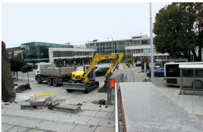
Anfang Oktober begannen die Arbeiten vor dem 44er Haus.
