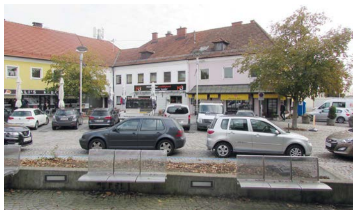
Beim Michaeliplatz werden bis Ende November die Parkplätze saniert und mehr Platz für Gastgärten geschaffen.
